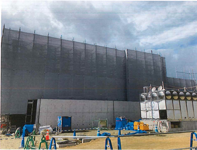
現場状況写真
