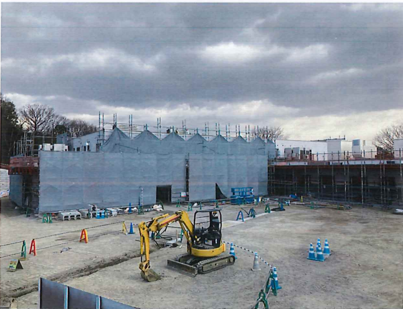
現場状況写真
