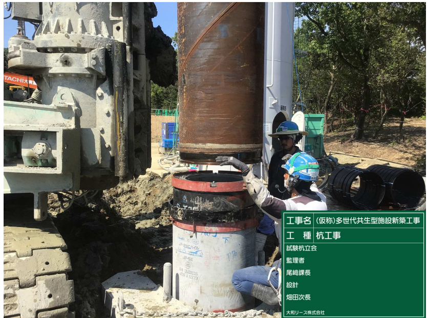
工事名 (仮称)多世代共生型施設新築工事 工種 杭工事 測点 No. 下杭建て込み状況 鉛直確認 大和リース株式会社
